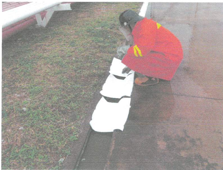
ภาพสมมุติเหตุการณ์ในการใช้แผ่นดูดซับคราบน้ำมันภายในรางระบายน้ำ มีการตรวจวัดค่าLELและค่าออกซิเจนตลอดเวลา
